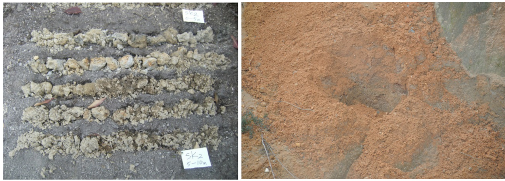
图9 钻孔中及塌陷坑壁上松散、破碎的土体
