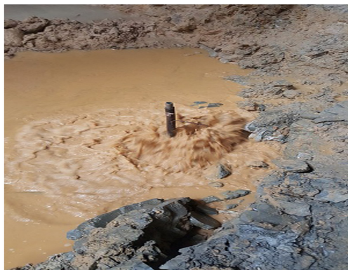
图 7 溶洞涌水
