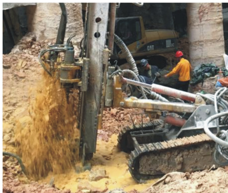
图 8 钻孔涌水
