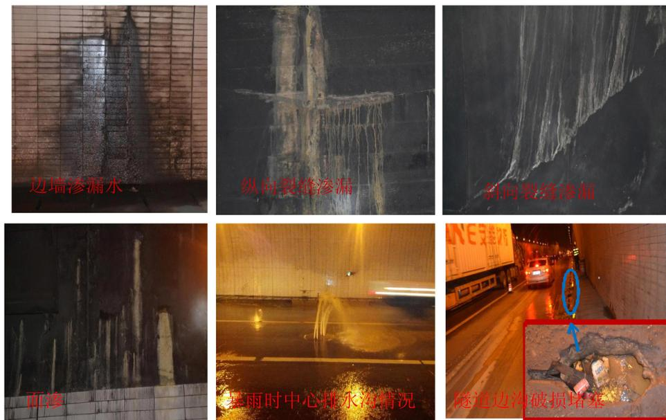
图2 隧道现场排水系统典型病害照片
