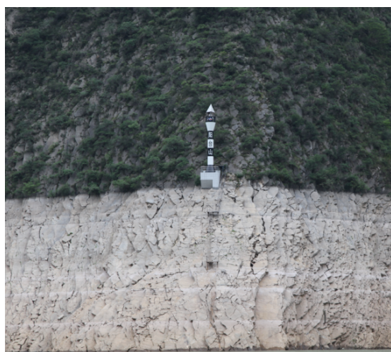
顺向碎裂岩体
