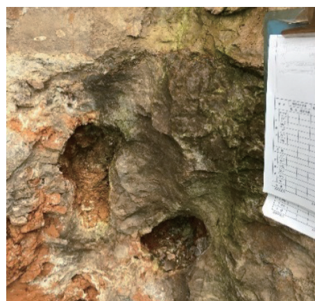
图 3 地下浅层岩溶发育状态(埋深 18.5 m)
