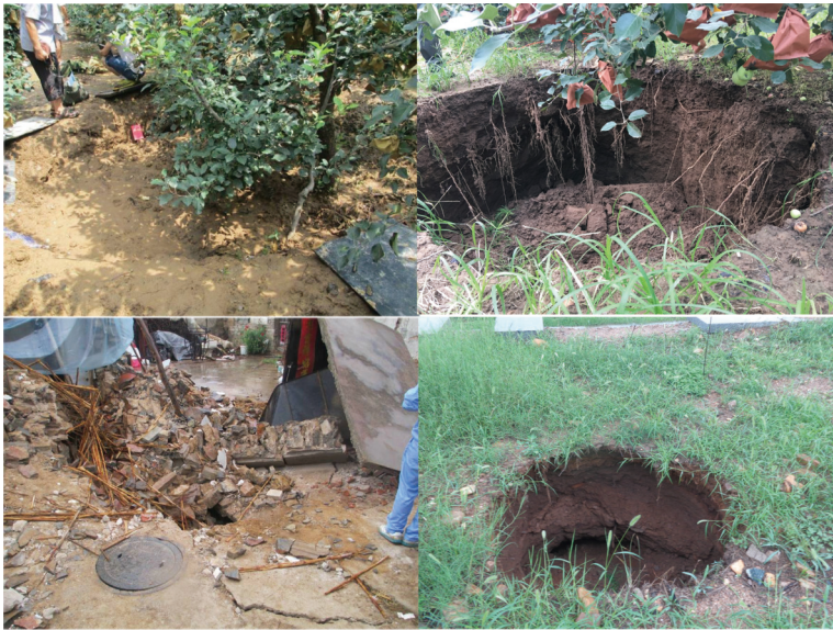
照片 3 研究区岩溶塌陷形态照片
