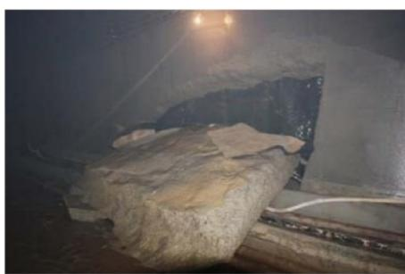
图 2 季家坡隧道二衬压裂<sup>[10]</sup>
