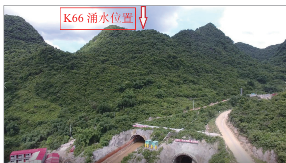
图6 泗顶特长隧道实际涌水位置(K66+660)
