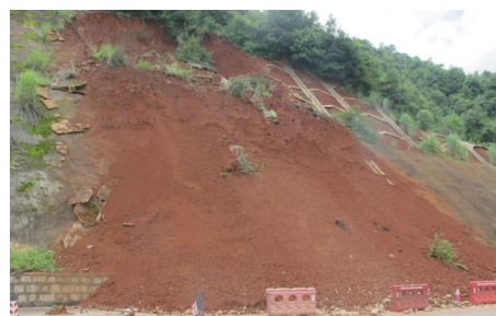
图 16 石林境内治理后的红黏土滑坡再次滑动
