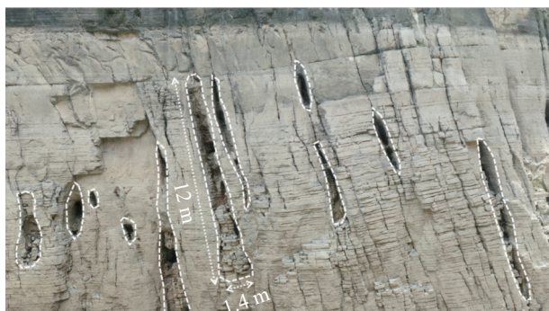
图3 箭穿洞段溶蚀/潜蚀劣化现象
