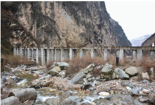
(c) 汶川七盘沟桩梁组合结构
