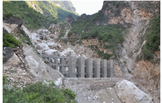
(b) 鲁甸龙头山镇泥石流沟桩梁组合结构
