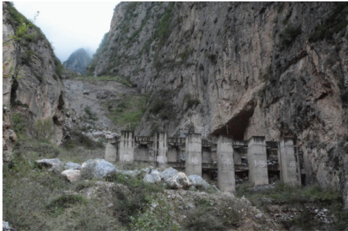
(a) 甘肃舟曲泥石流桩梁组合结构
