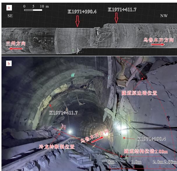
a—隧道断裂处云俯视图; b—隧道被断裂左旋错动实景(镜向北)
