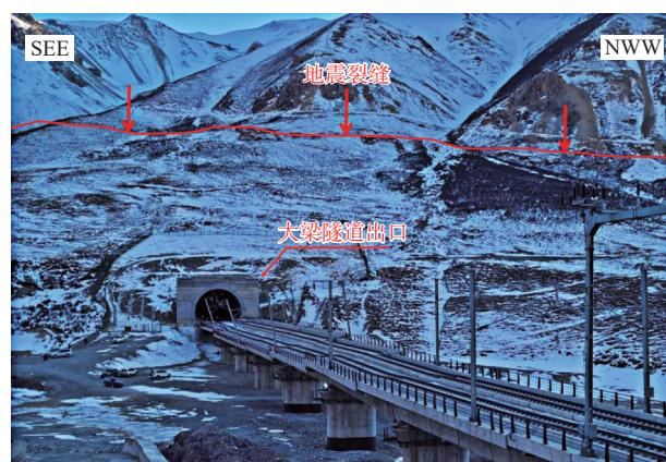
图 5 发震断裂大角度切穿大梁隧道
