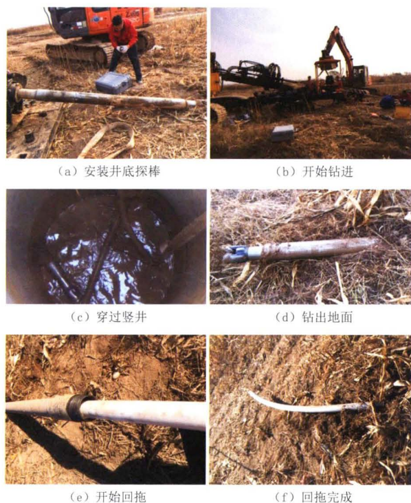
图 17 辐射孔施工过程
