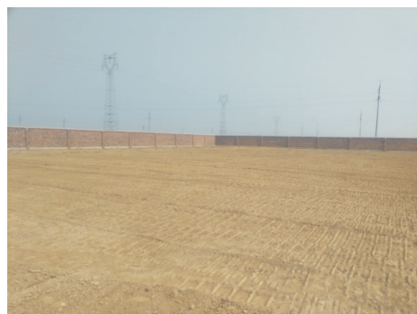
图4 铺垫完成的场地
