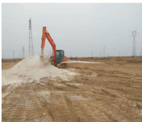
图3 灰土垫层施工
