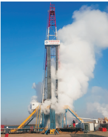
图 3 压缩空气洗井
