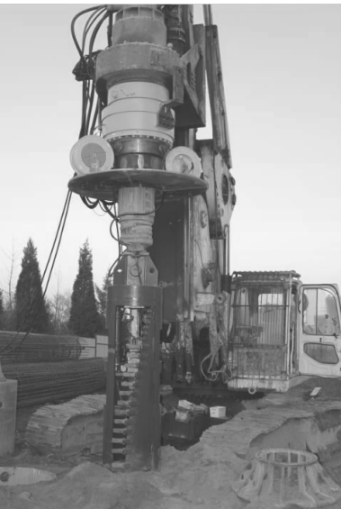
图 8 试验现场 Fig.8 Testing site
