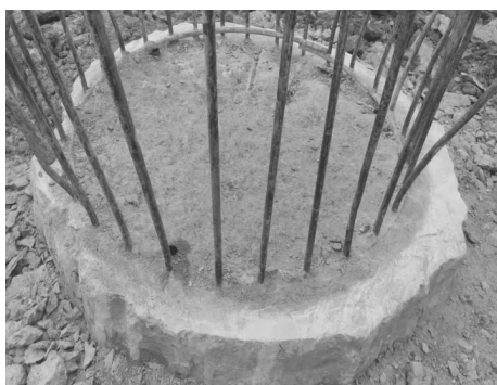
图 2 钢筋笼位移
