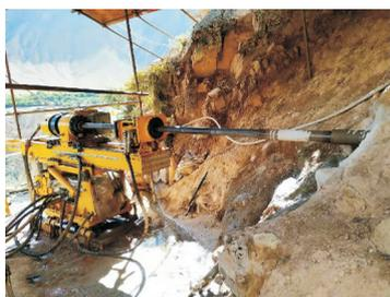
2019年10月底,铁一院负责的川藏铁路洛隆段察达隧道勘察钻探现场又传捷报,由西北有色713队使用陕西探XDQ-1200轻便型钻机施工的水平超前地质预报钻探孔,75
