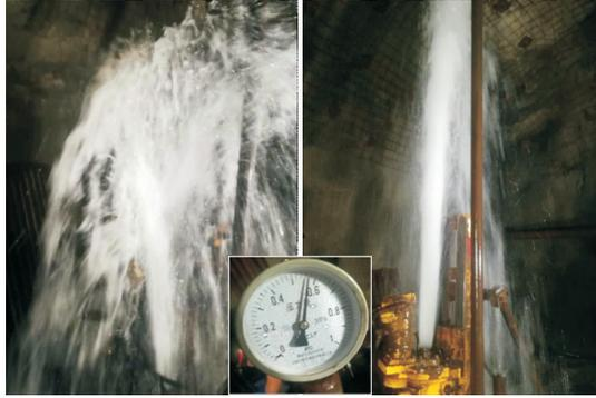
图3 KZK5313 钻孔孔内涌水情况
