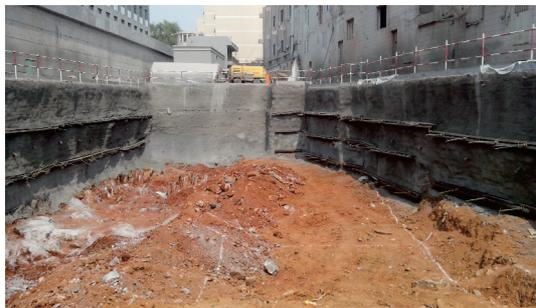
图3 微型钢管桩支护施工后的现场情况
