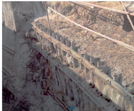
图4 微型钢管桩加固处理后的现场情况
