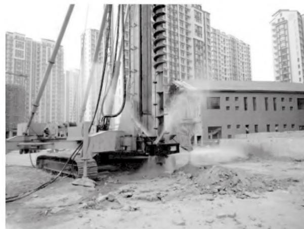
图 6 山东聊城旋喷搅拌施工现场
