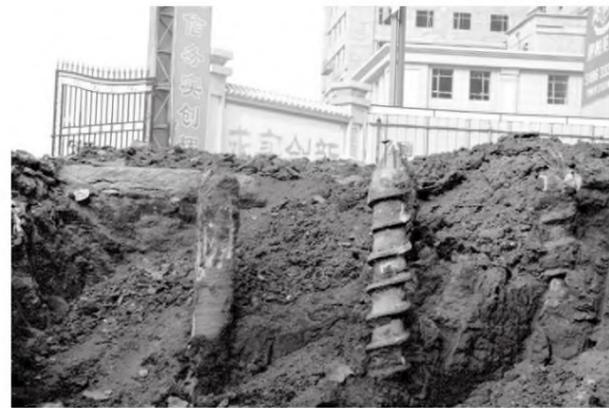
图4 工地现场挖出的螺杆桩
