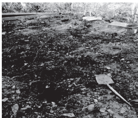
图 7 钻探结束场地恢复
