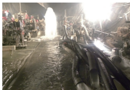
图 2 现场钻孔勘探
