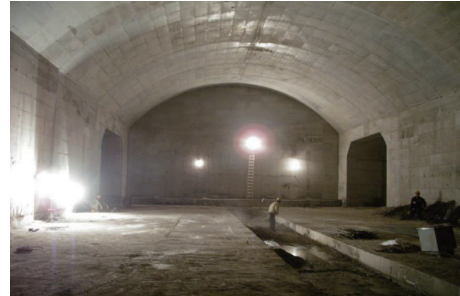
图 6 隧道衬砌实际效果 Fig.6 Actual finished tunnel lining
