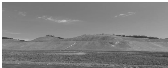
图5 施工后的项目区
