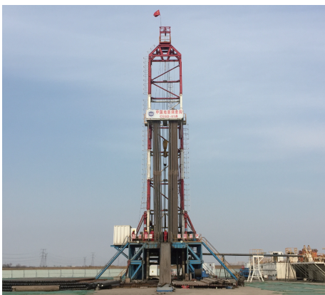
图8 地热资源调查钻探工程
