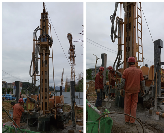
图8 浅层地温能钻探施工现场
