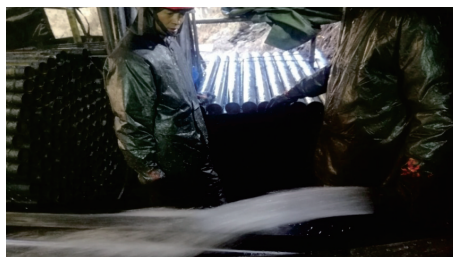
图6 钻孔涌水
