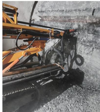
图7 隧道超前地质预报水平冲击取心钻进施工
