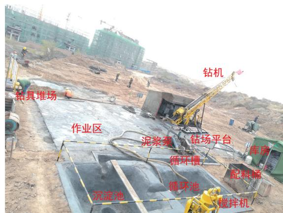
图3 处理后的钻场及冲洗液循环系统
