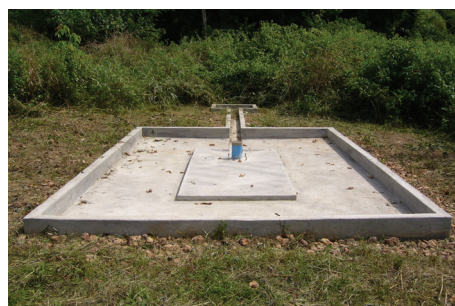
图6 施工完成的水井井场
