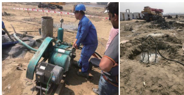
图3 后压浆施工现场
