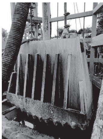
图8 深圳施工现场
