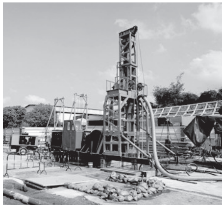
图7 厦门施工现场
