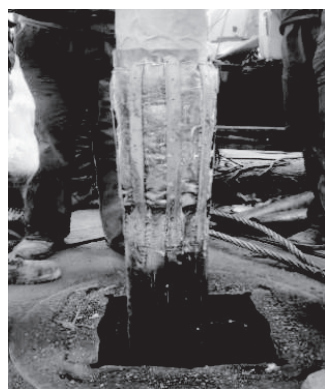
图2 止水伞现场实物
