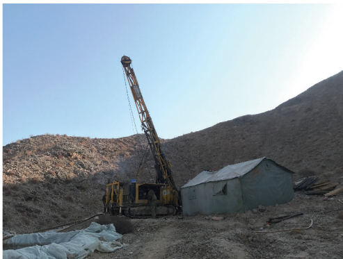
图3 施工现场 Fig.3 Drilling site
