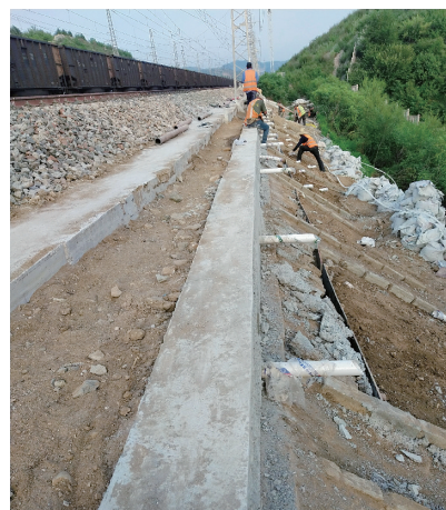
图2 K319+200~380下行侧路基下沉及注浆挡墙施工照
