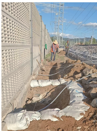
图1 K319+200~380上行侧路基下沉及注浆挡墙施工照
