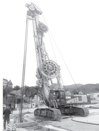
图7 XTC80/55型铣槽机现场施工
