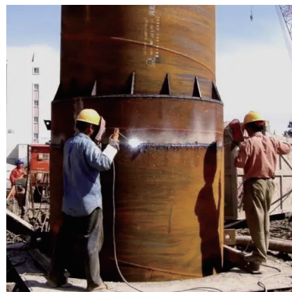
图4 大口径套管人工焊接
