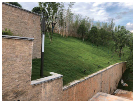
图15 刷坡减载及防水护坡施工完成后边坡
