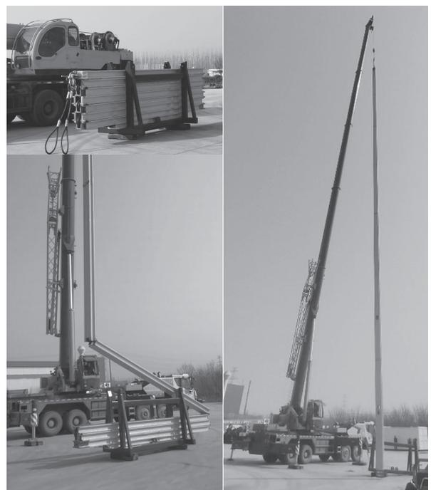
图10 导轨施工提升过程
