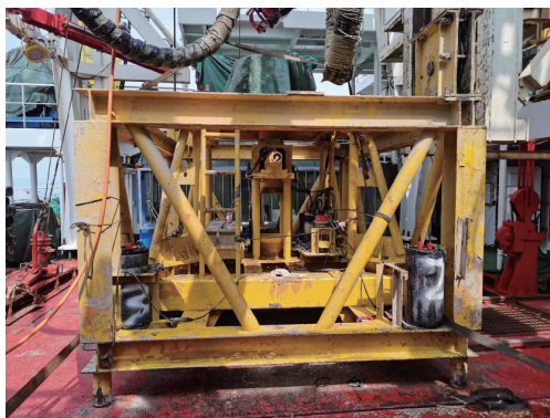
图8 电池分配器安装
