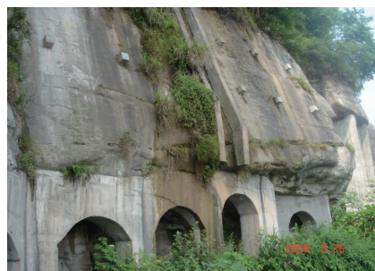
图8 支撑墙+锚固+排水
