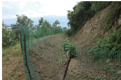
图9 拦石堤、落石槽
