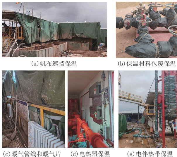
图 2 现场保温处理措施
