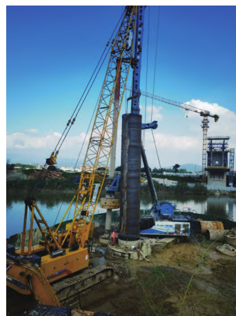
图 12 2650S 搓管机施工现场
