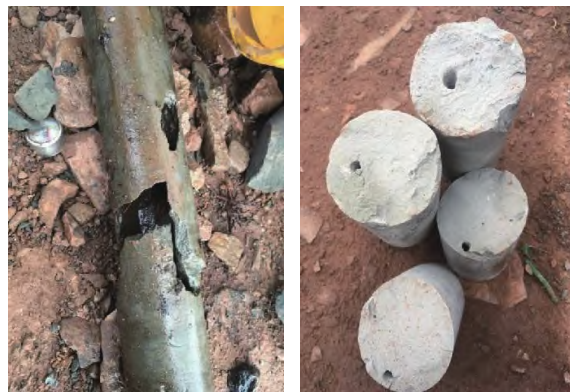
(b)套管内水泥柱被抽吸形成的贯穿通道
