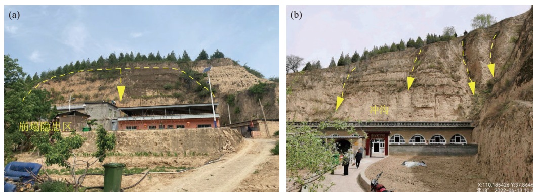
a. 滑移式崩塌隐患; b. 倾倒式崩塌隐患
