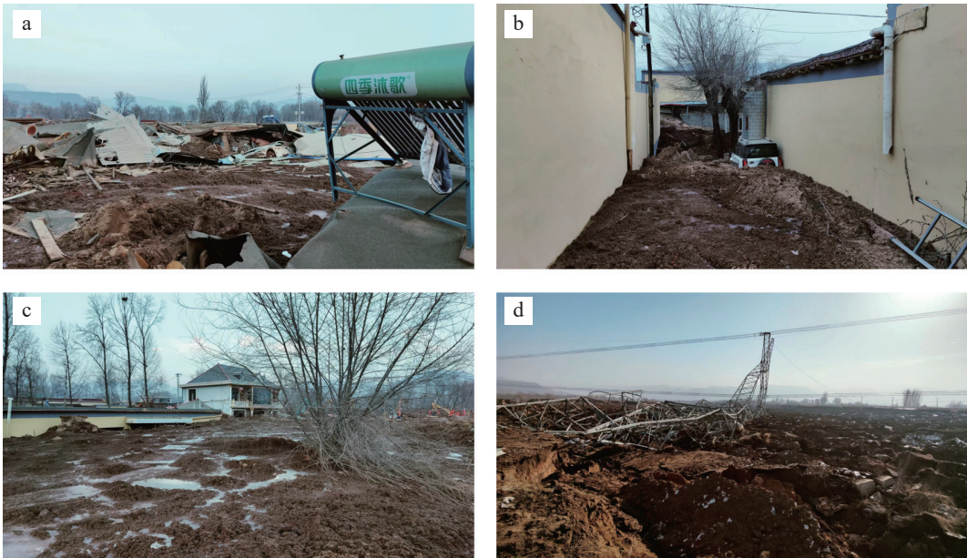
a. 堆积区房屋掩埋; b. 堆积区村道堆积; c. 堆积区大范围堆积体; d. 形成区高压输电塔倾倒折断
