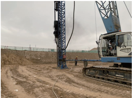
(a) 注水孔成孔施工
