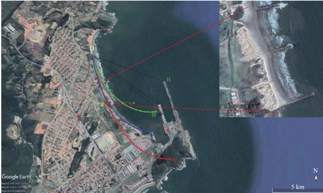
图 3 巴西因比图巴码头防波堤建设对海岸稳定性影响和应对工程 (底图: 谷歌地图)
