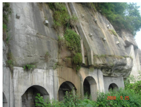
图1 支撑墙-锚固联合支护治理措施
